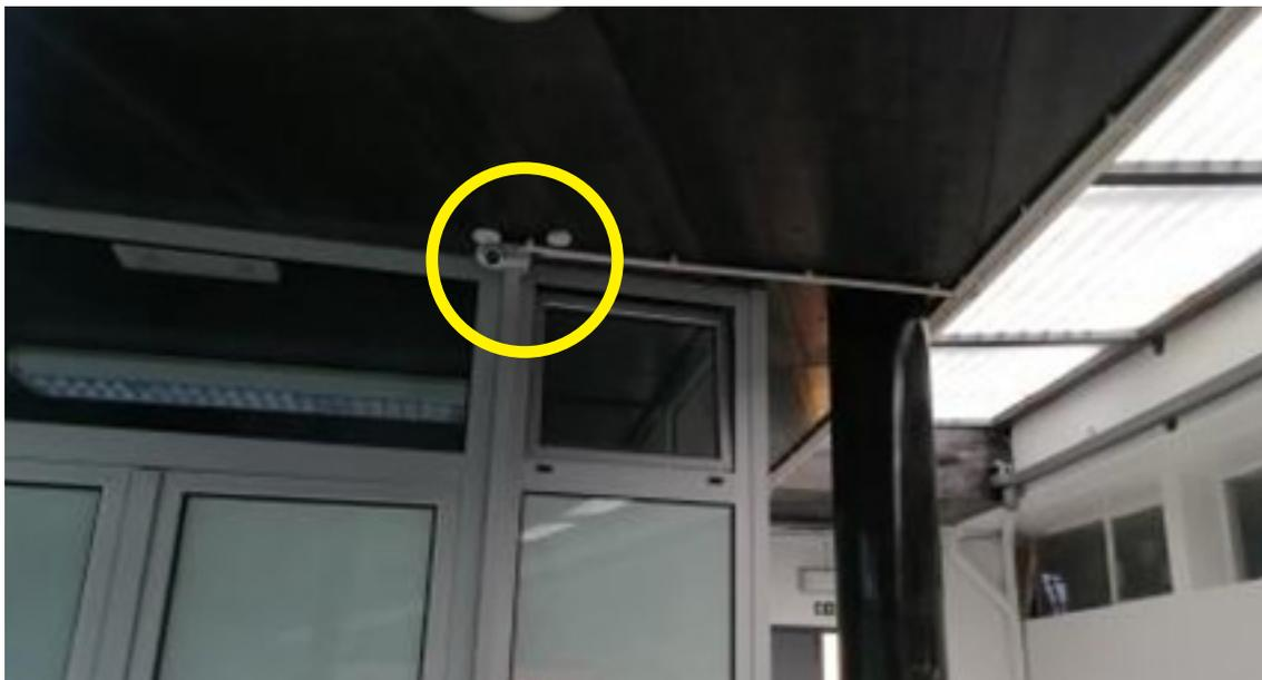
Fotografia 11 – Câmara fixa de captação de imagem no edifício da Zona Técnica
