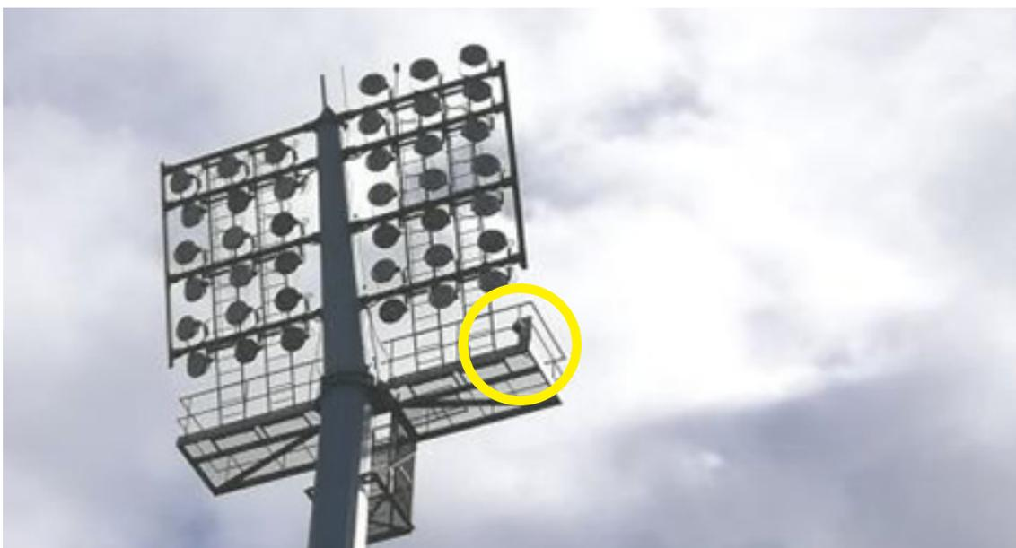
Fotografia 2 – Câmara fixa de captação de imagem na torre de iluminação 2
